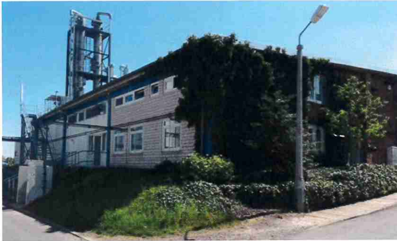
Bereich Gießereiservice: Produktionsgebäude mit Destillationskolonnen
