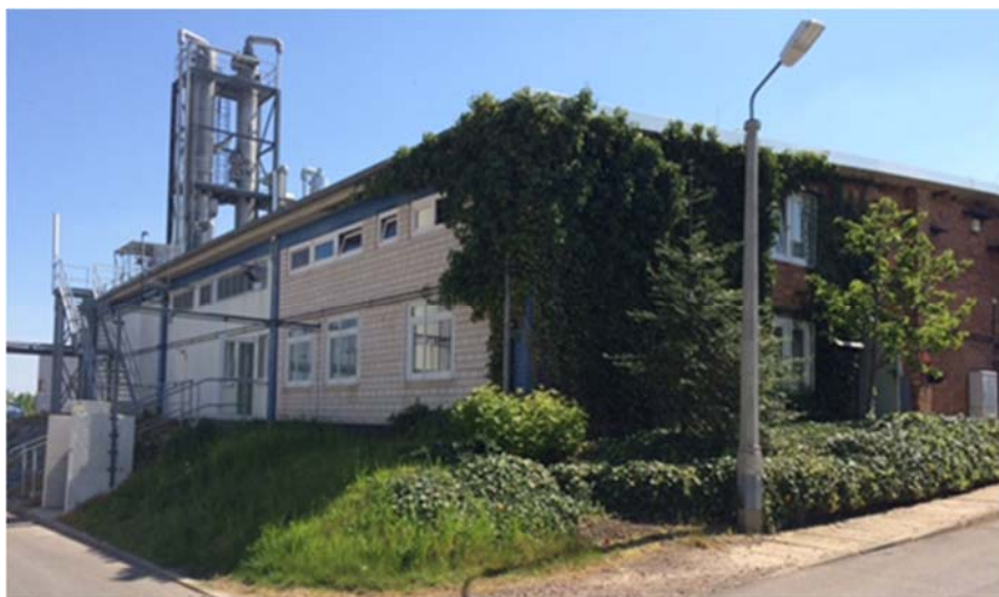
Bereich Gießereiservice: Produktionsgebäude mit Destillationskolonnen
