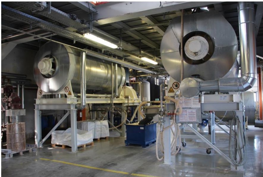
Bereich Trocknungsservice: Produktionshalle mit Schaufeltrockner
